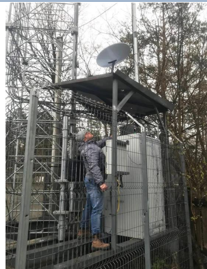
图表41：伊尔平使用星链的移动基站
