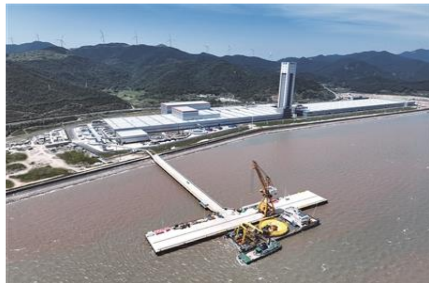
◎ 东方电缆宁波北仑海缆生产基地
