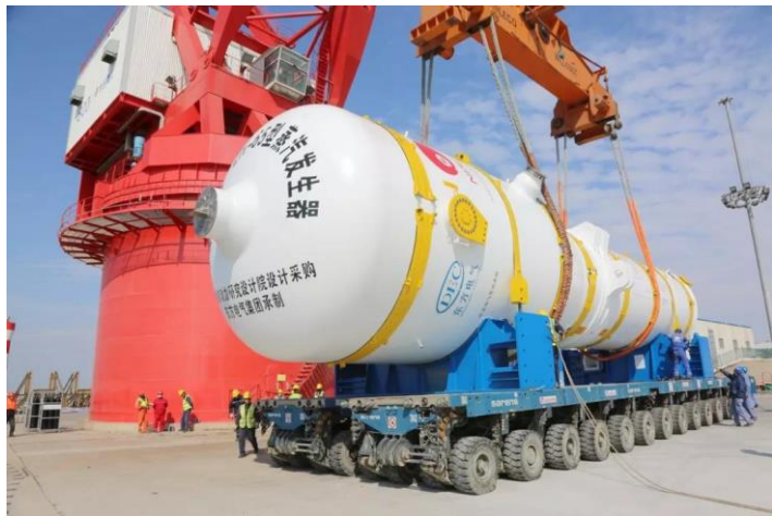
图：“华龙一号”首堆蒸汽发生器
