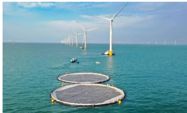
图28 挪威 Ocean Sun 浮力环式海上光伏方案
