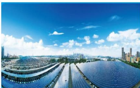
东风日产乘用车分布式光伏一期项目
