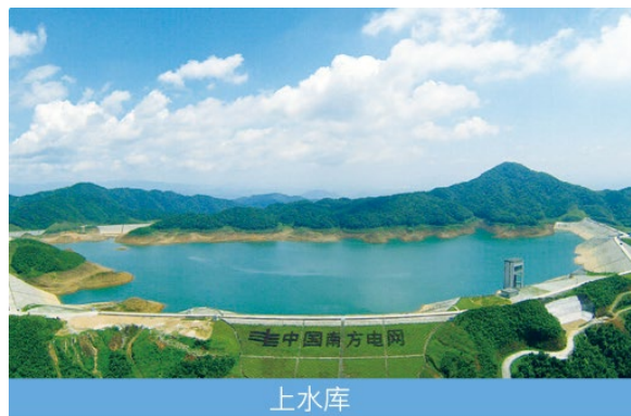
图 6：南网储能清远抽水蓄能电站
