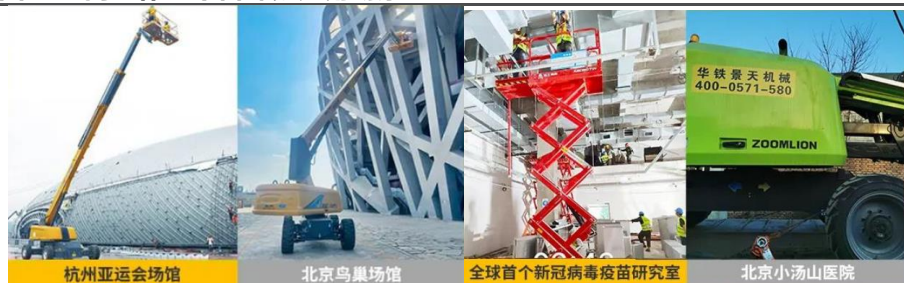
图17: 高空作业平台部分应用场景
