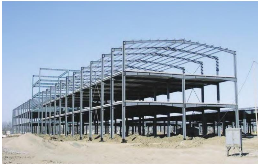
图表 22. 轻钢结构建筑
