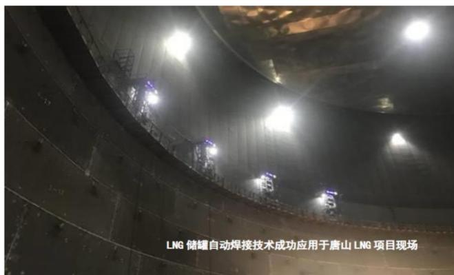
LNG 储罐自动焊接技术成功应用于唐山 LNG 项目现场
