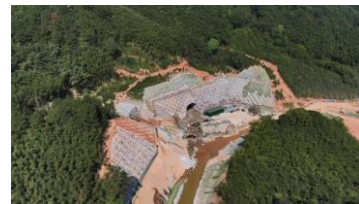
注：图为已开工的浪江抽水蓄能电站
