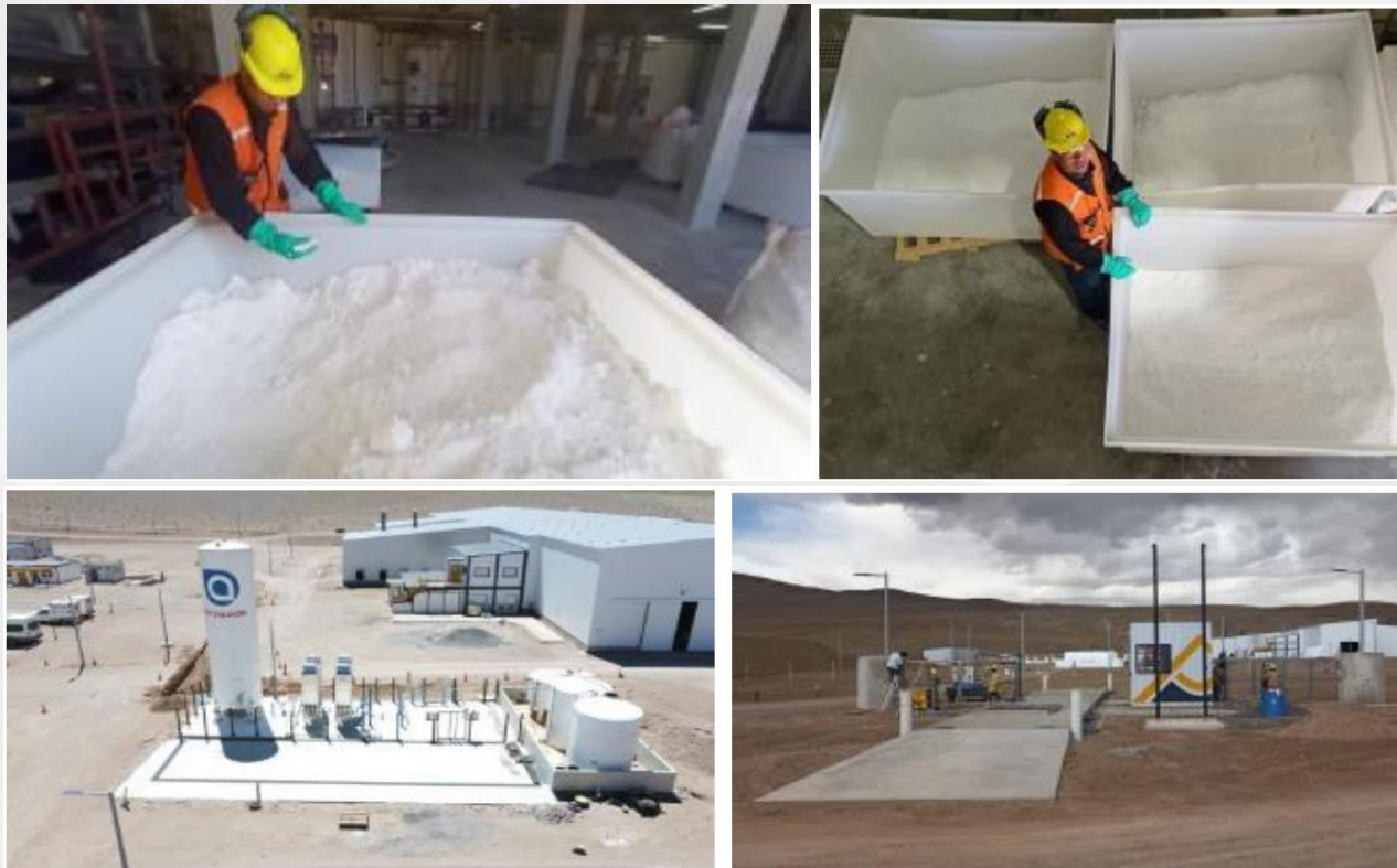
图17：Salar del Rincon项目--2000吨/年碳酸锂项目运行调试中
