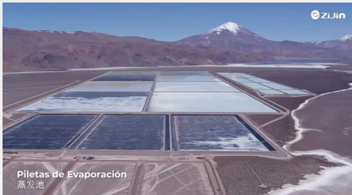
图24：阿根廷3Q盐湖项目蒸发池
