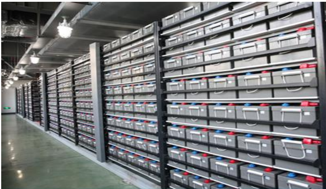
图表5：铅炭电池在固定式储能上的应用场景
