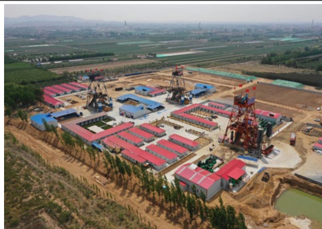
图18：纱岭金矿建设工程
