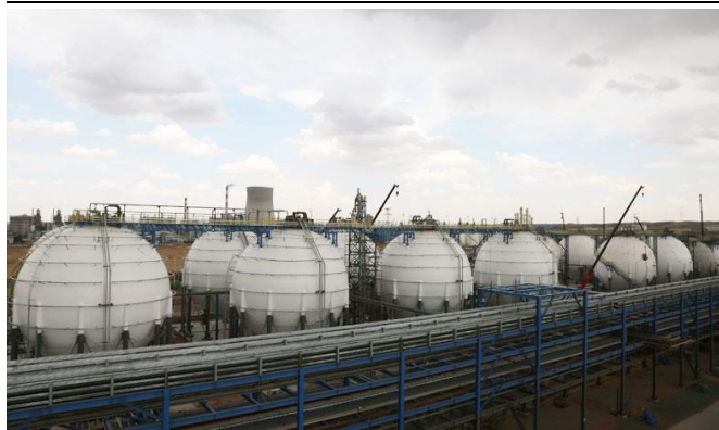
图表 116. 神华宁煤球罐工程
