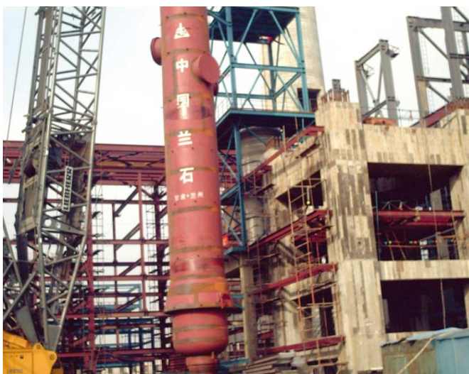
图表 112. 大连石化公司 220 万吨年重整催化装置中四合一连续重整反应器
