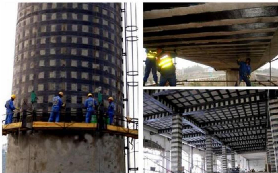
图表 51.碳纤维在建筑与民用工程中的补强应用
