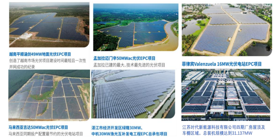
图 14：永福股份光伏 EPC 项目
