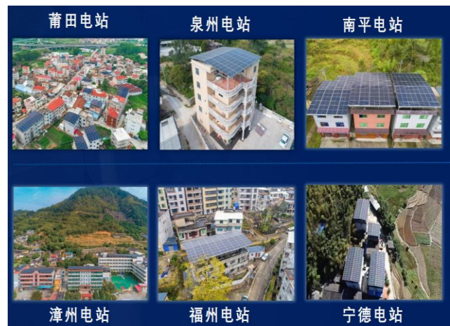
图 35：永福股份户用光伏电站系统集成产品“整县推进”案例
