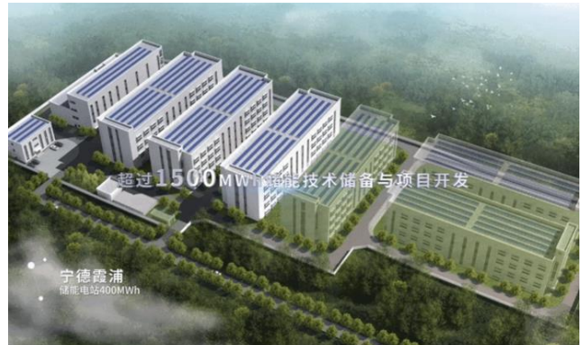
图 25：宁德霞浦储能项目
