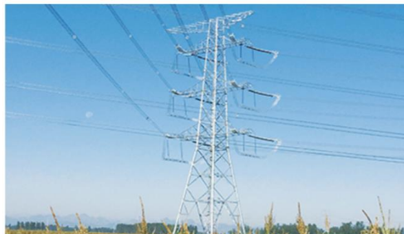
蒙西~天津南1000kV特高压交流输电线路工程
