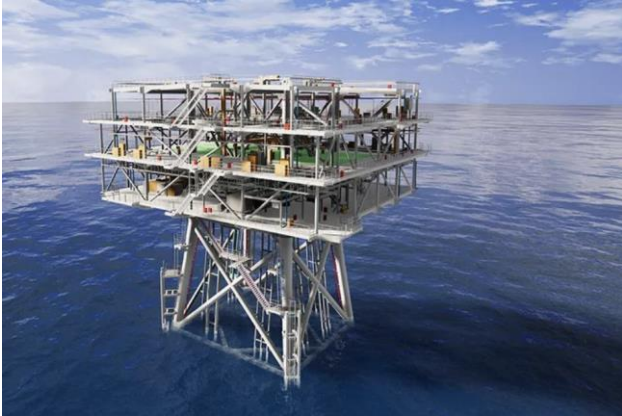
图 44：明阳阳江海上风电场项目
