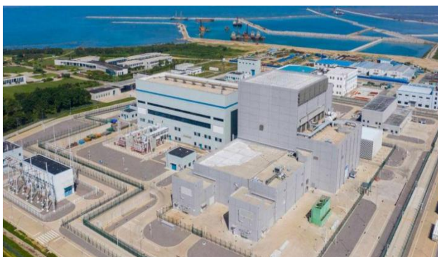
图 39: 石岛湾高温气冷反应堆核电示范厂
