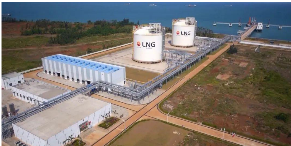
图12: 中石油海南 LNG 储备库全景图
