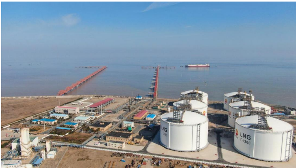
图10: 中石油江苏 LNG 接收站全景图
