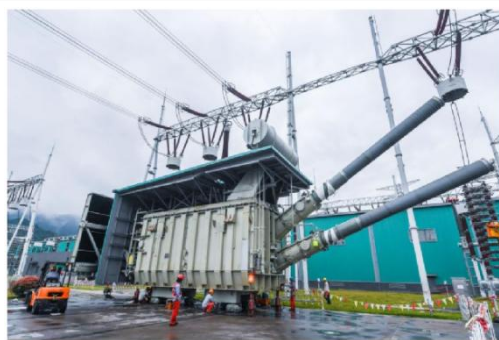
图 14: 公司换流变分接开关应用于从化±500kV 换流站
