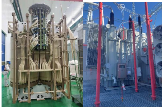
图 13: 首台 1000kV 分接开关应用于蒙西-天津南特高压线路
