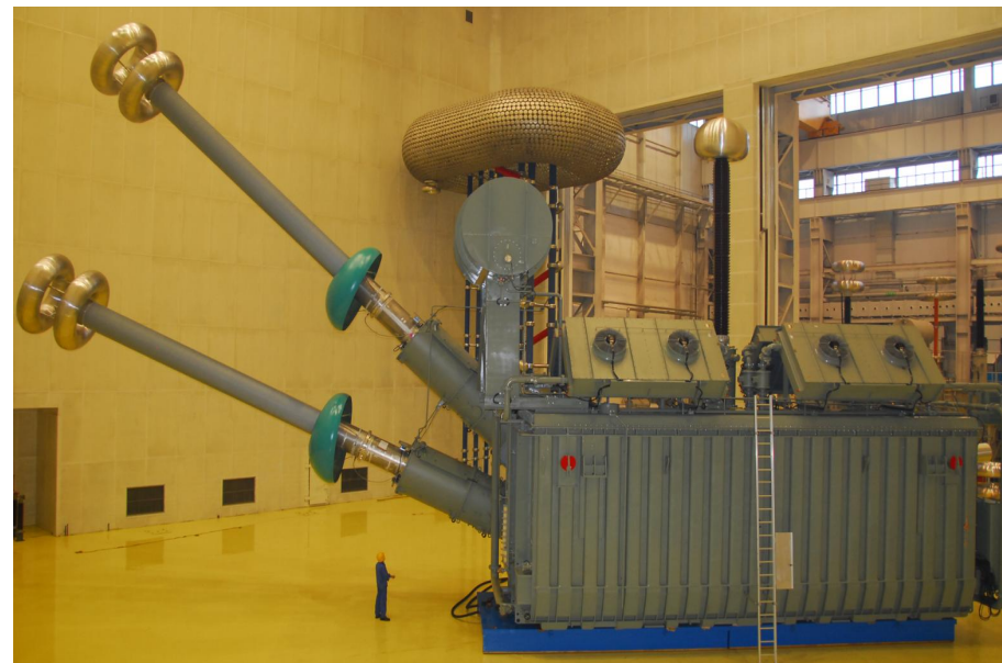
图39：换流变压器
