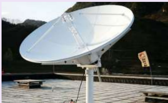
图表：固定地面站天线
