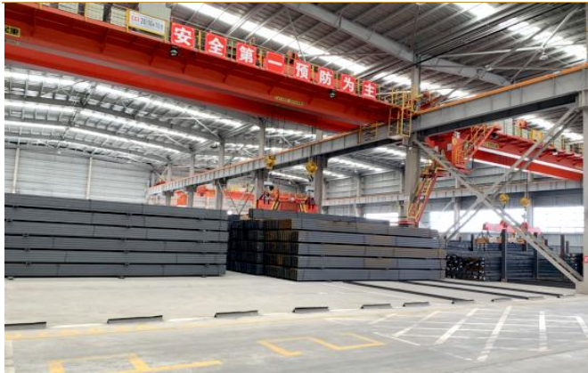
图 22：公司晋南工业服务综合体
