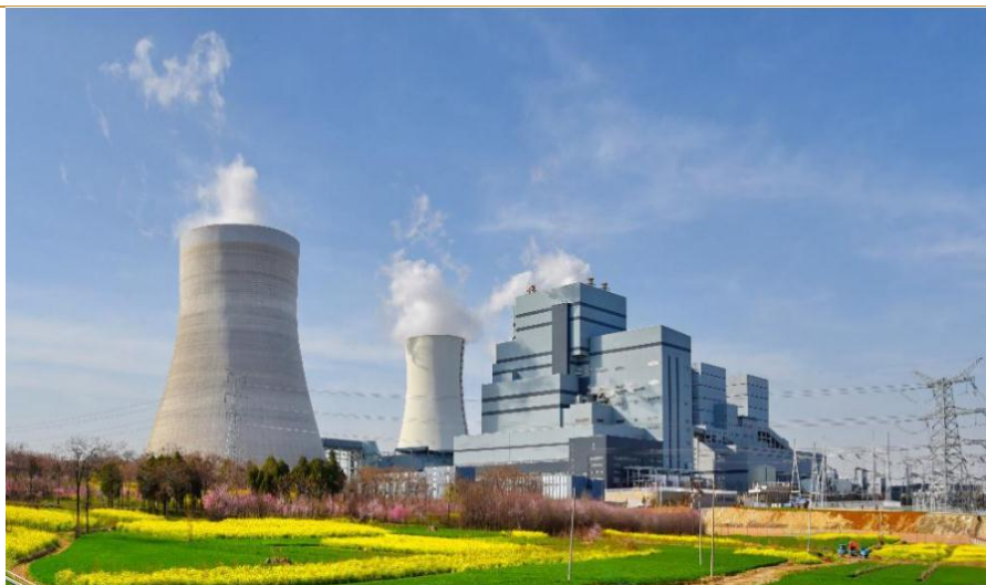
图 13：申能安徽平山电厂二期 1350MW 超超临界燃煤机组
