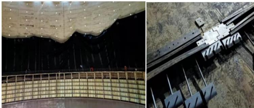
图11：气柜橡胶密封膜主对相应的储存装置进行橡胶密封
