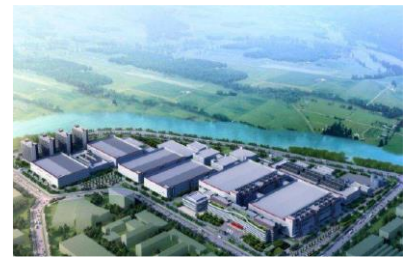
武汉弘芯半导体制造有限公司 一期洁净室工程、一般机电工程
