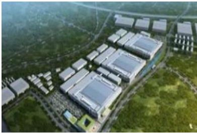
长江存储科技有限责任公司 通用配电工程P1-2包
