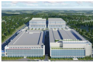
合肥晶合集成电路股份有限公司 L40洁净室工程
