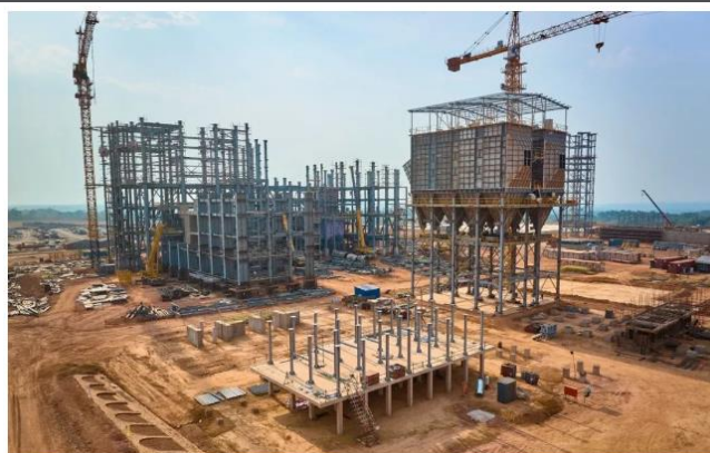
图27：冶炼厂正进行钢结构安装，公司预计 2024 年 Q4 投产
