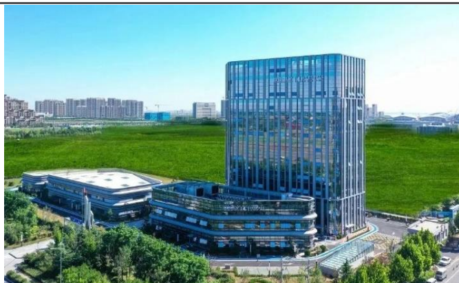
图50: 上合航天产业园大楼
