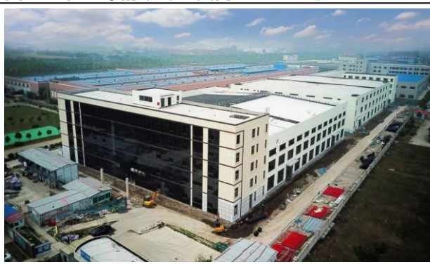
图29：在建中的银河航天南通卫星超级工厂
