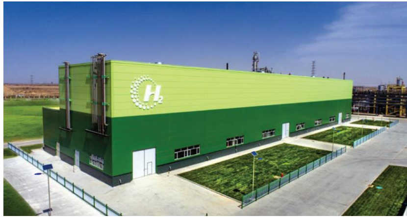
图33: 宝丰能源光伏发电及电解水制氢储能项目
