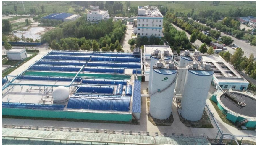
图6：环保工程建设服务项目实景图
