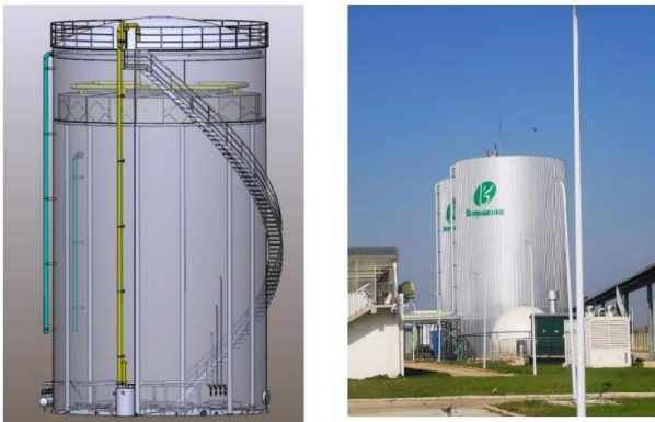
图5：AE 厌氧反应器示意图及实景图
