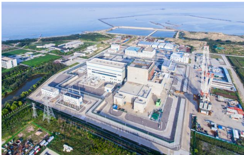
图 34: 石岛湾高温气冷堆示范工程全貌
