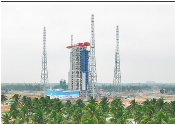
图 77: 海南商业航天发射场航拍图
