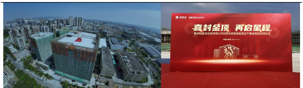
图59：创意包装智能制造生产建设项目已完成厂房主体结构的封顶
