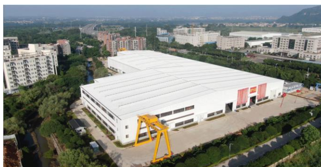
图47：桂林储能装备数字化、干式变压器数字化工厂
