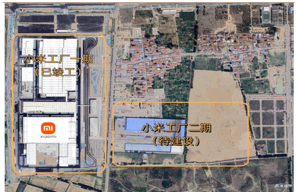
图 5：小米汽车工厂施工进度图
