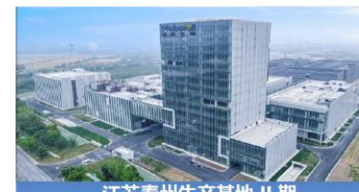
江苏泰州生产基地 II 期 (在建、实景图)
