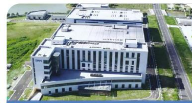
上海金山生产基地 (在建、实景图)
