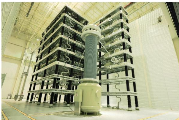
图9：直流断路器示意图
