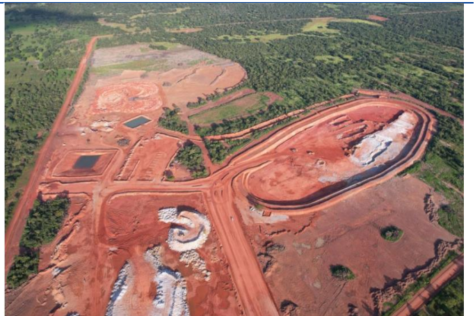
图 45: Goulamina 项目原矿厂和尾矿厂
