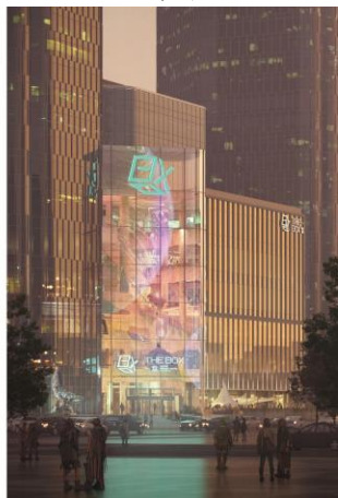
北京THEBOX朝外：传统商场昆泰商城改造
