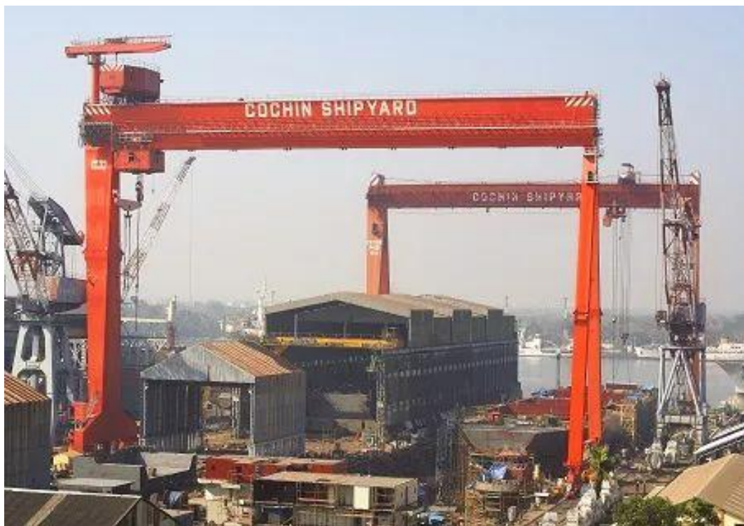
科钦船厂是印度唯一能建造和维修航母的船厂
