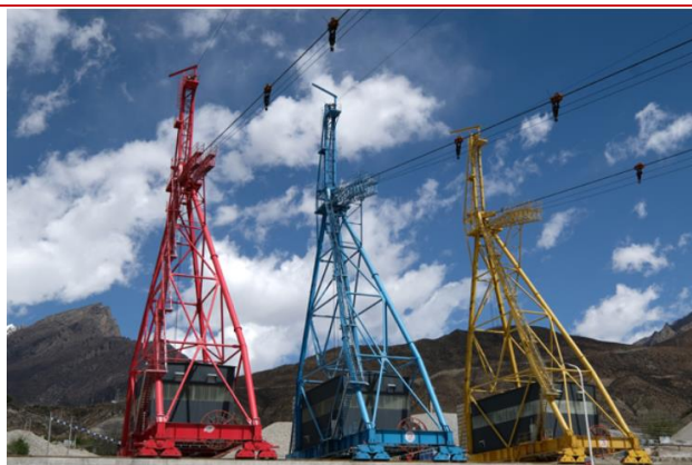
图表37: 西藏加查水电站缆索起重机
