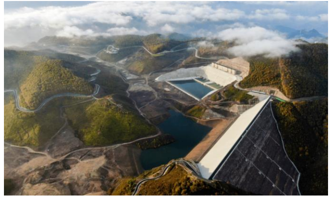
图 92：全国投运容量最大的丰宁抽水蓄能电站
