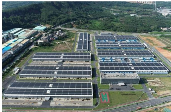
图 20: 腾讯天津高新云数据中心分布式新能源微电网项目
