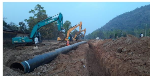
图 128: 泥浆管道项目更新
