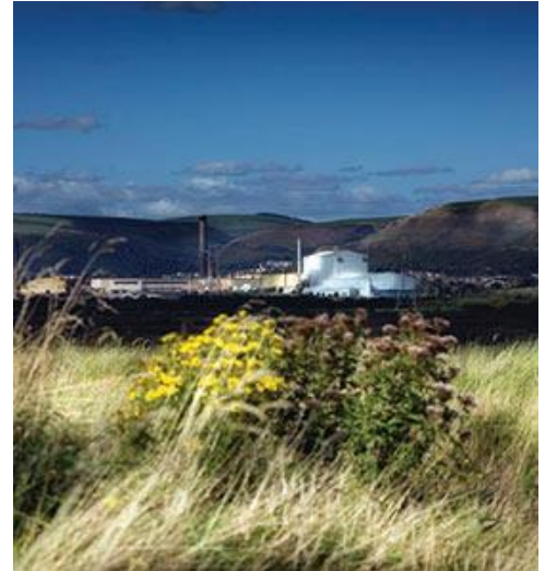
图 97: 塔塔钢铁塔尔伯特港
