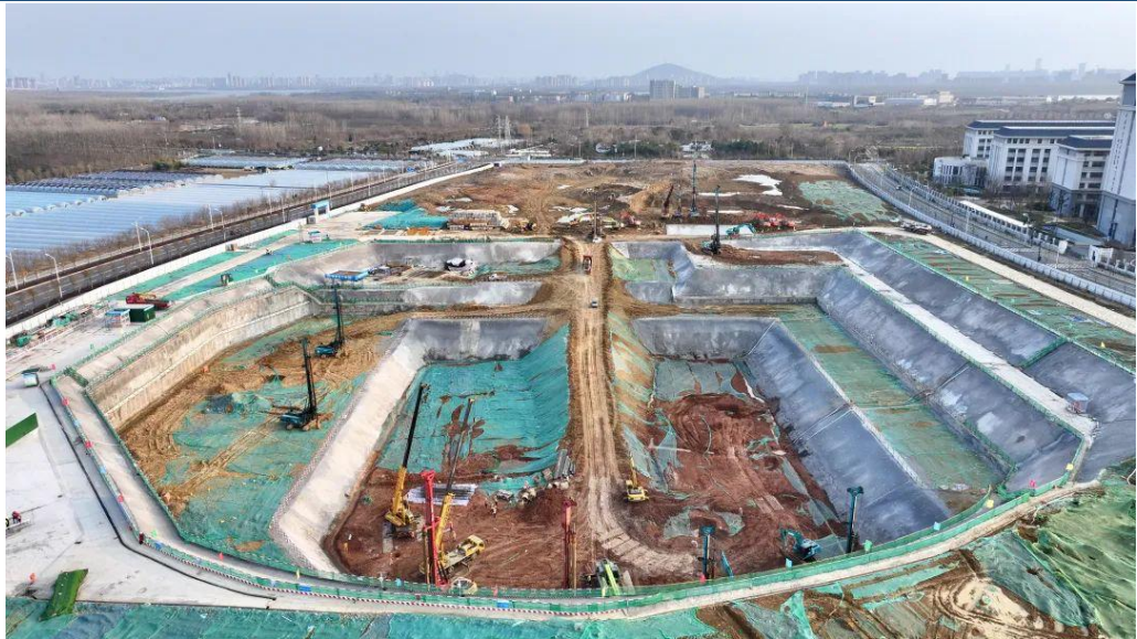
图表 29: 紧凑型聚变能实验装置 (BEST) 项目建设现场
