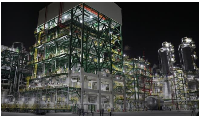
图24:公司独山能源 PTA 装置
