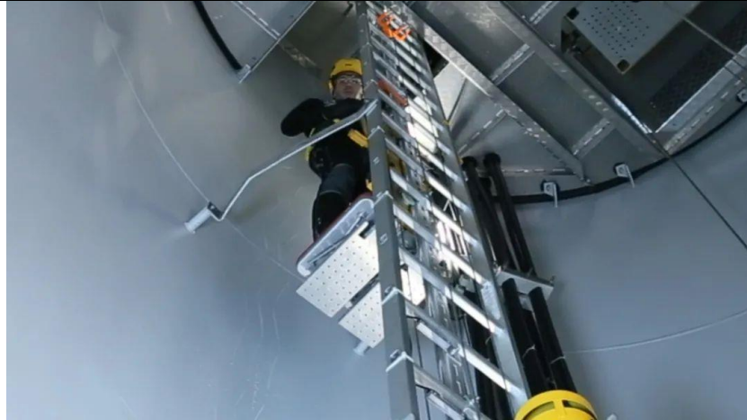
图 18: 作业人员使用风电高空安全作业设备
