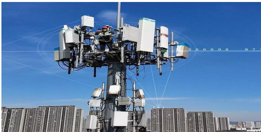
图 54：南京市民用无人驾驶航空试验区 5G-A 通感基站现场安装实景
