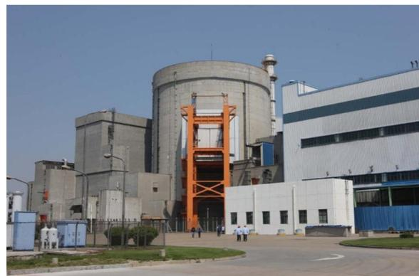
灰色建筑物为核岛，圆柱体建筑物内安装了核反应堆，白色建筑为常规岛，安装了汽轮机和发电机组
