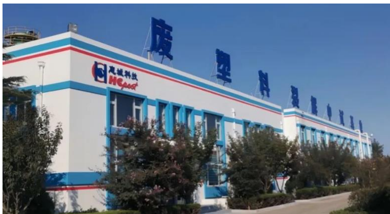
图18：惠城环保裂解中试基地现场照片
