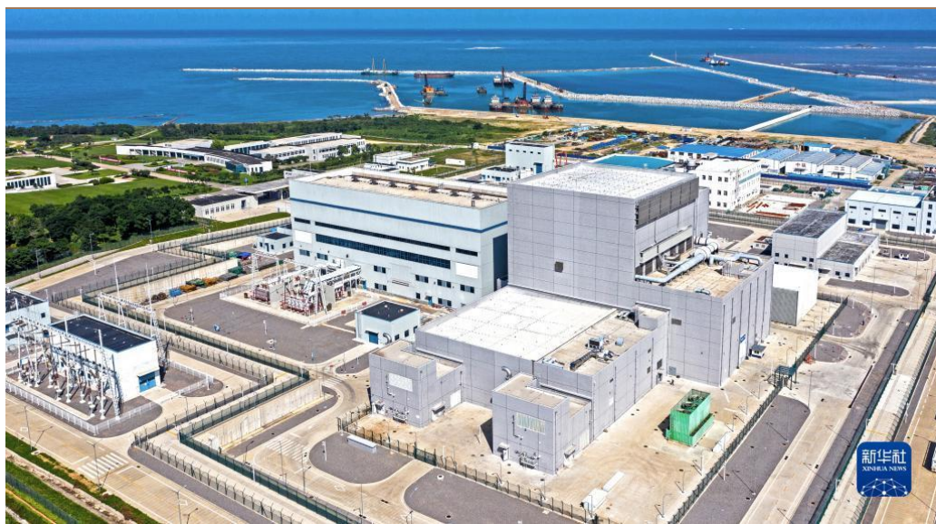
图 28：华能石岛湾高温气冷堆示范工程
