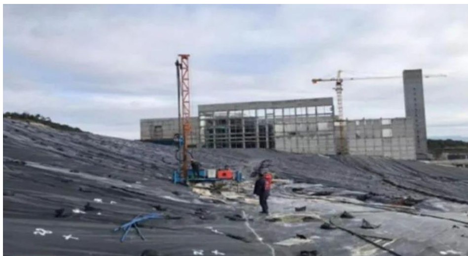
图18：广州市第七资源热力电厂存量垃圾开挖
