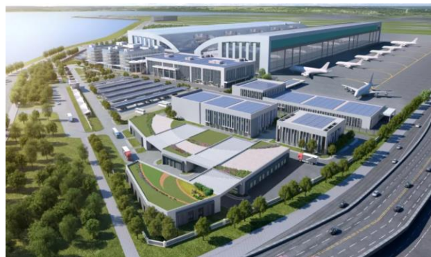
图 19：厦门太古翔安机场维修基地项目
