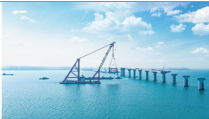
图 20：厦门翔安大桥
